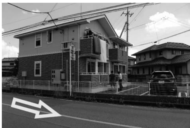
手前の道路を矢印のように濁流が流れた。
