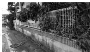
水が引いた後の被災状況 （家の周り）
