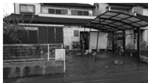
水が引いた後の被災状況 （全体）
