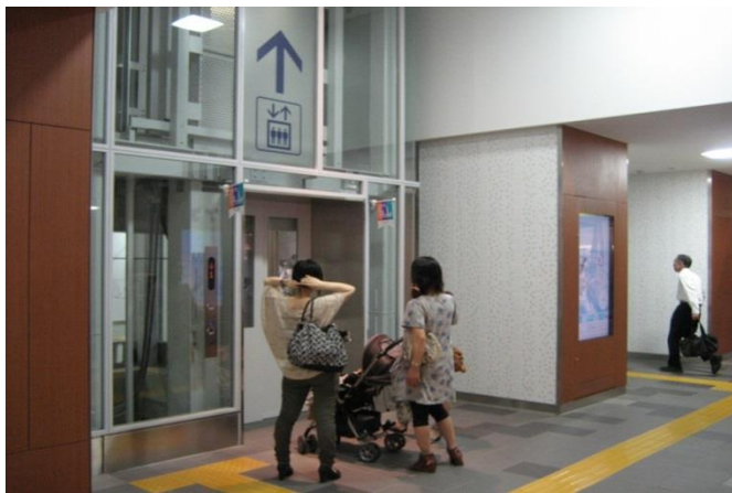
エレベーター
